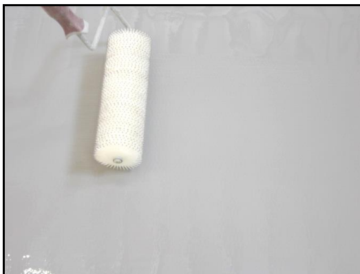
Obr. 4 - Aplikácia valčeka na odvzdušnenie v druhej vrstve.
