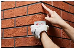
Po zaschnutí lepidla sa vzniknuté škáry na rohoch vyplnia špeciálnou, na to určenou hmotou (z rovnakého materiálu, z akého sú vyrobené obklady).
